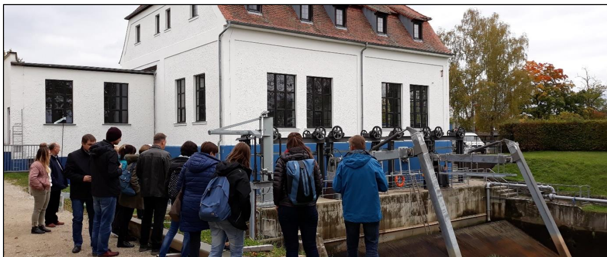
Rys. 83: Elektrownia wodna przy Erlangen (Niemcy)
