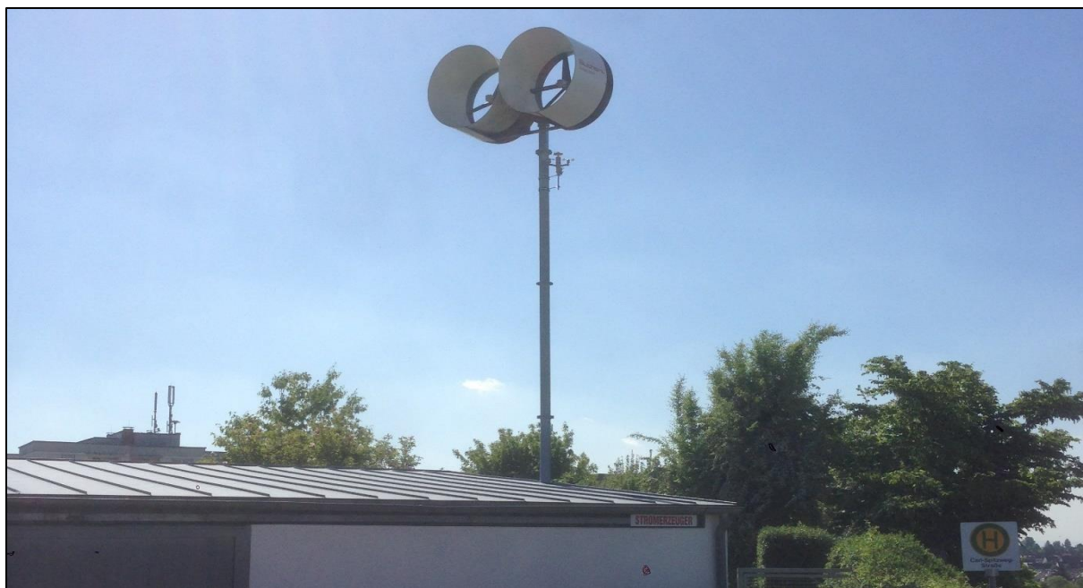
Rys. 85: Mała turbina wiatrowa na budynku mieszkalnym
