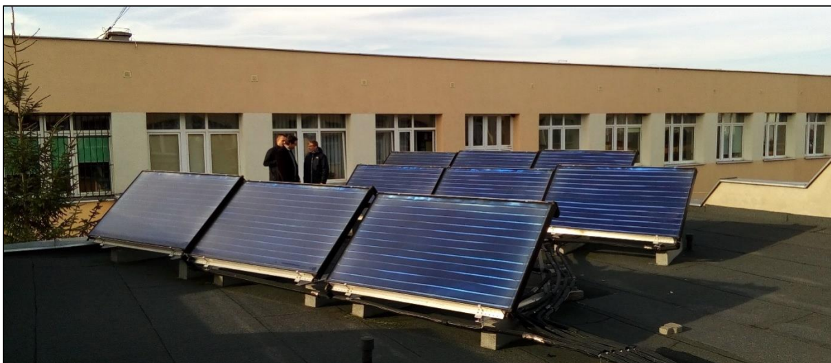
Rys. 74: Solarny system grzewczy na dachu szkoły w Hajnowce
