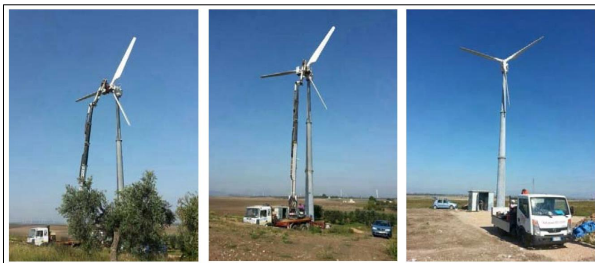
Rys. 88: Budowa małej turbiny wiatrowej we Włoszech
