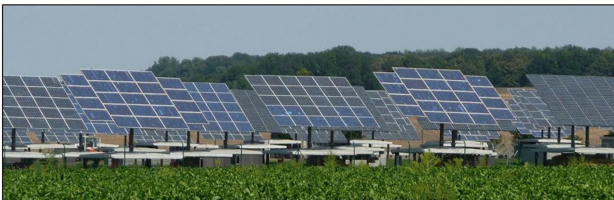
Rys. 75: Instalacje fotowoltaiczne (tutaj na wolnej powierzchni)
